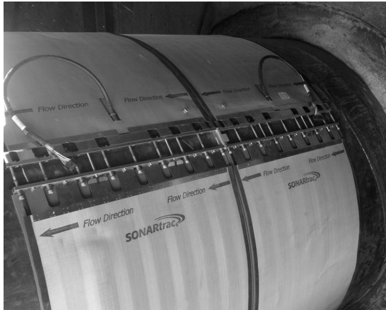
Figura 6 Banda del sensor instalada en el caño
