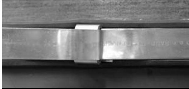
Figura 28 Instalación final de la abrazadera de la banda
