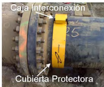
Figura 15: Disposición conceptual del sistema HALO™ y foto del sistema operando en instalaciones del cliente en terreno.
