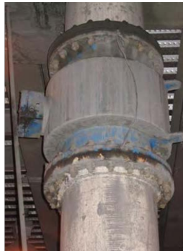
Figura 4: Medidor Electromagnético
