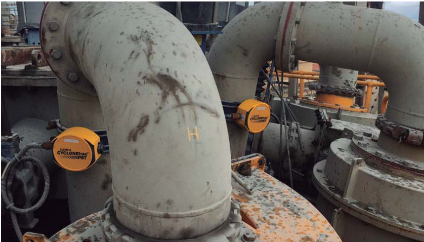
Las baterías de ciclones de Cidra cuentan con tecnología puntera que mejora la productividad total del proceso.
