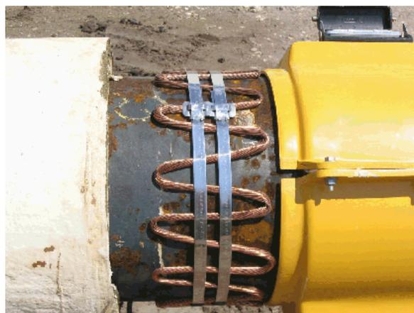
*Banda de Conexión a Tierra Instalada en la Tubería*
