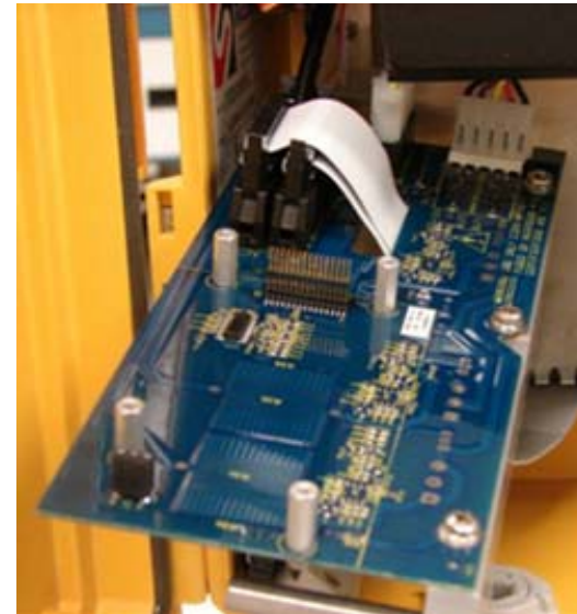
Figura 6 Tablero Fieldbus retirado
